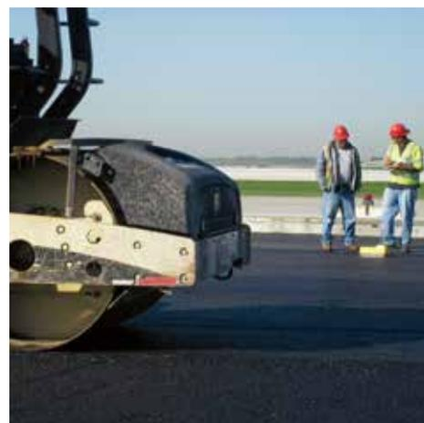
Измерения плотности проводятся на покрытии, уложенном по технологии с применением Rediset® LQ на проекте модернизации аэропорта О'Хара.
